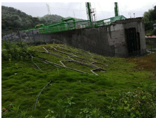
调节池边坡防护及绿化
