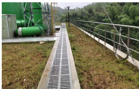
调节池屋顶绿化及排水
