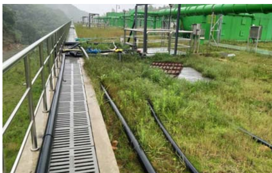
调节池屋顶绿化及排水
