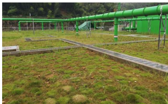
调节池屋顶绿化及排水
