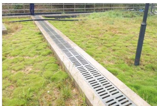
调节池屋顶绿化及排水
