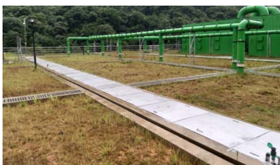
调节池屋顶绿化及排水
