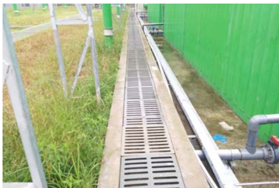
调节池屋顶绿化及排水
