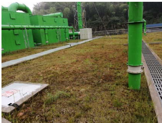
调节池屋顶绿化及排水
