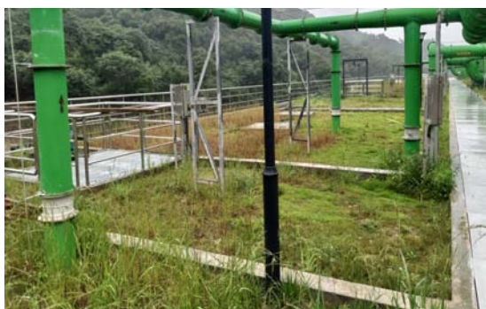
调节池屋顶绿化及排水
