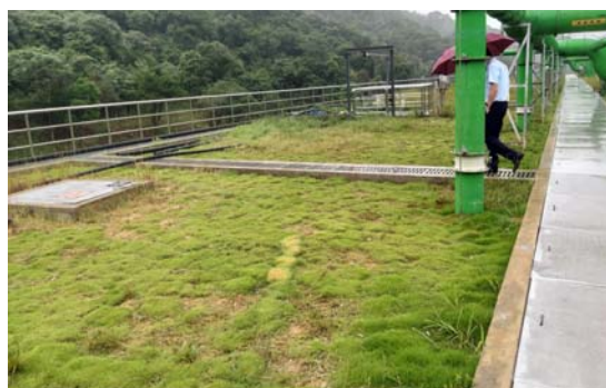
调节池屋顶绿化及排水
