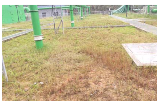
调节池屋顶绿化及排水
