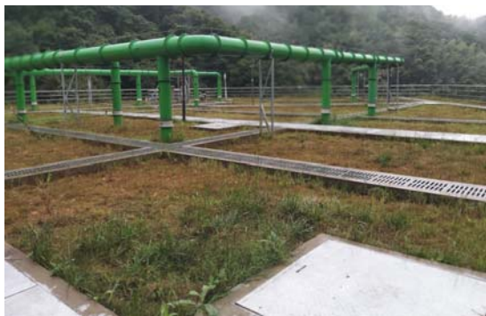
调节池屋顶绿化及排水
