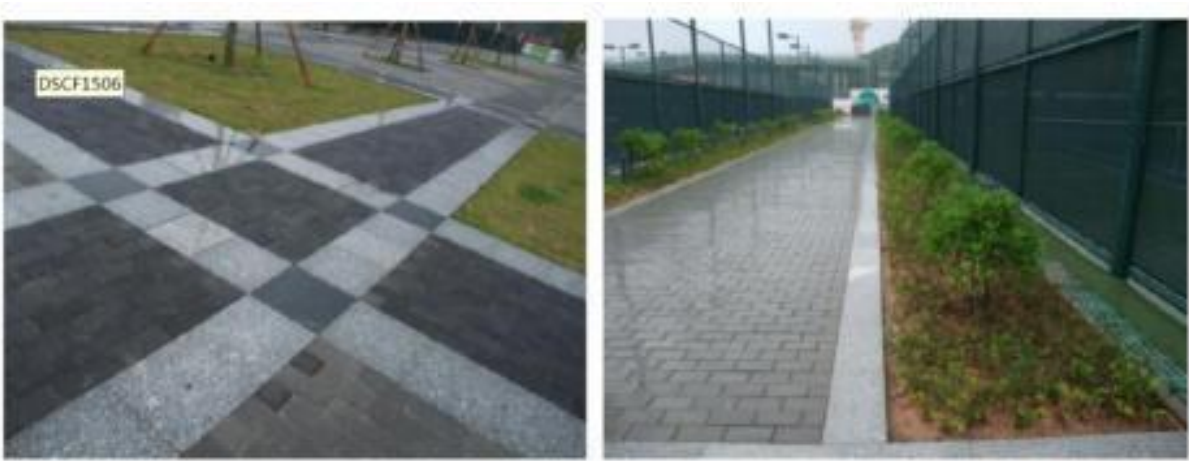
图 17-4 透水铺装示意图
