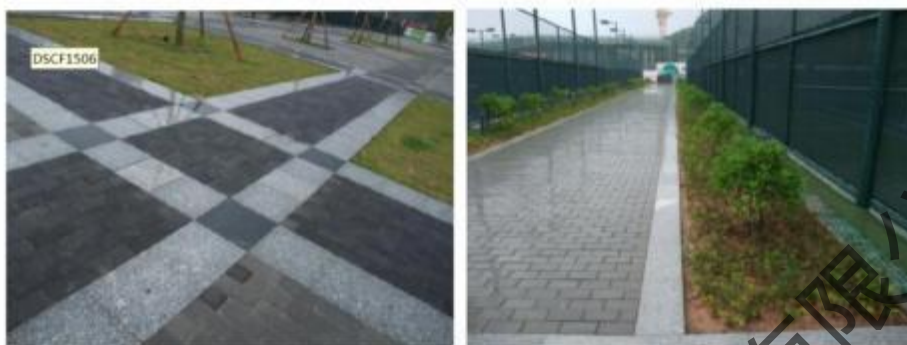
图 6-4 透水铺装示意图
