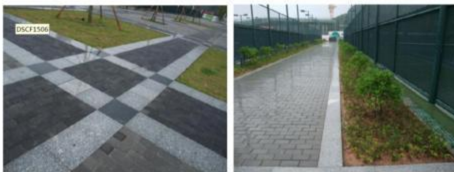
图 6-4 透水铺装示意图
